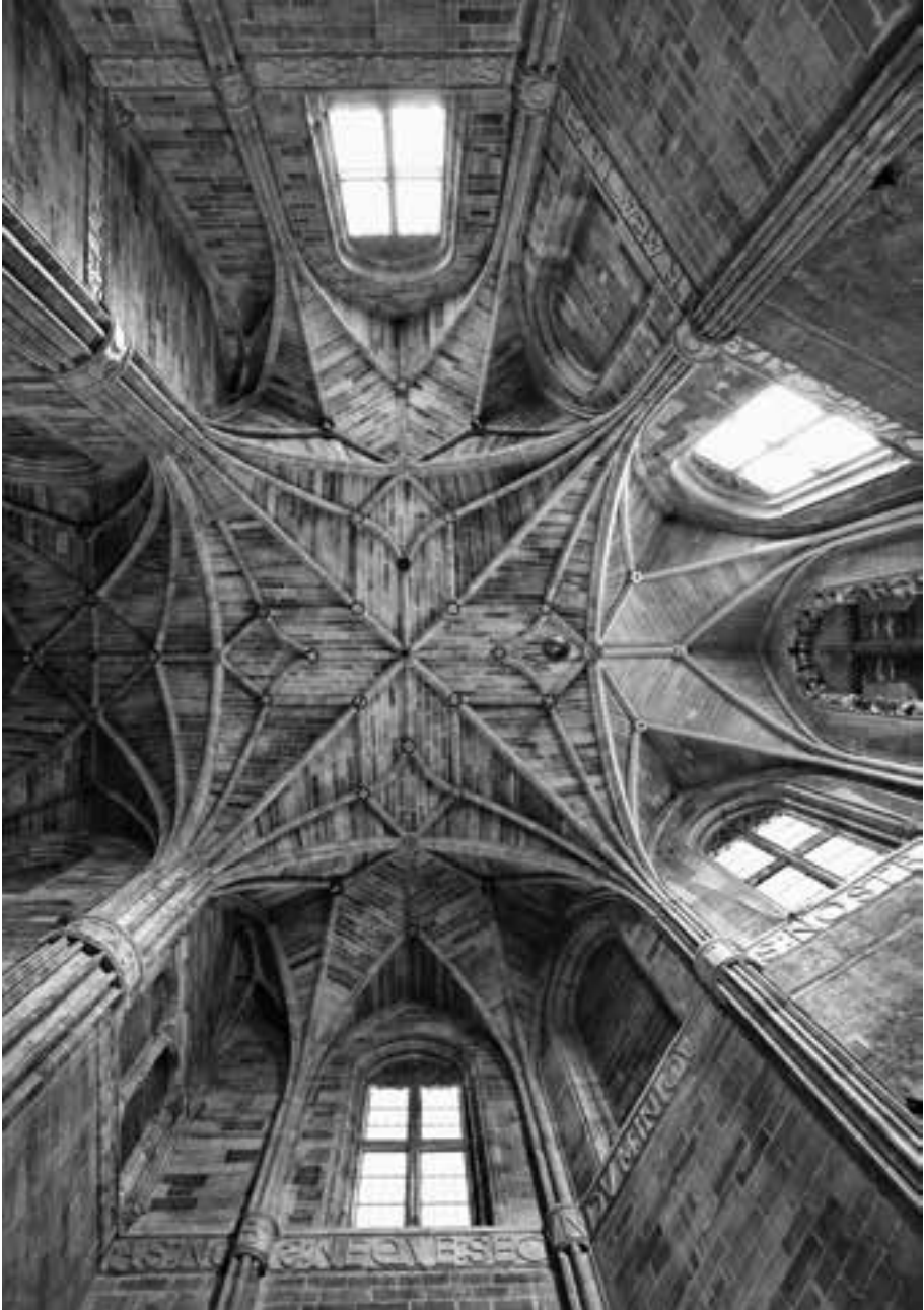
FIG. 11. Casalarreina. Cabecera trebolada de la iglesia, con terceletes sin nervios cruceros en los medios seisavos que conforman el trébol..
