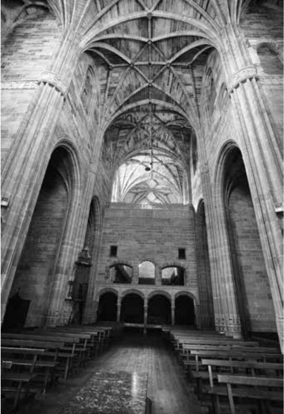
FIG. 13. Casalarreina. Nave, con bóvedas de terceletes atravesados, y coro.
