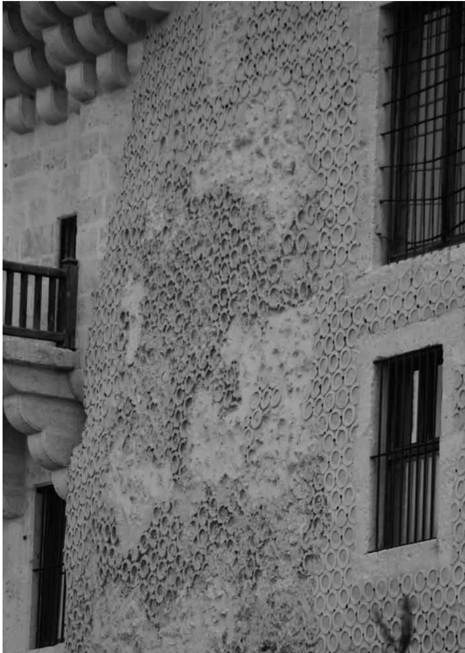
Fig. 12. Revestimiento del castillo de Cuéllar (Segovia).
