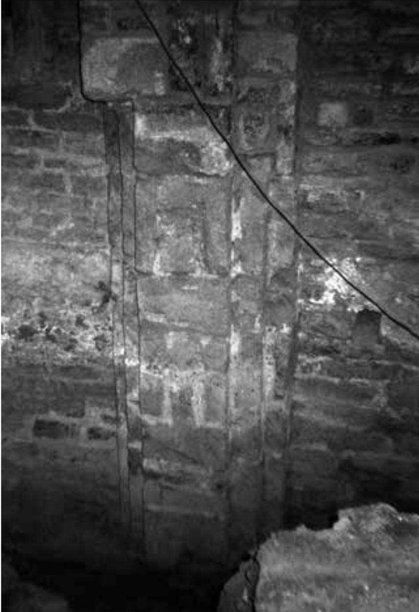
Fig. 7. Roda de Isábena. Catedral. Interior, nave meridional, tramo adyacente al ábside, ángulo suroeste. Pilastra de triple articulación apta para soportar una bóveda de arista, transformada en doble para sostener una bóveda de cañón sobre fajones sencillos. Fotografía de Fernando Galtier Martí.
