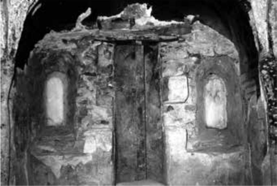
FIG. 12. Roda de Isábena. Catedral. Ábside central, interior. Ventanas de la cripta actual entre las que restaban las huellas del arranque de un arco axial, tal como podían verse en 1976 y que fueron disimuladas hacia 1985. Fotografía de Fernando Galtier Martí.
